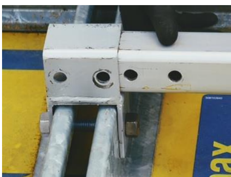
Otwory kotwiczące słupka powinny zbiegać się z otworami gniazda
