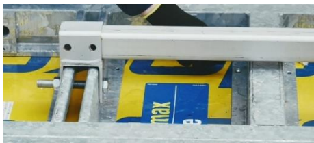
Otwory kotwiczące słupka powinny zbiegać się z otworami gniazda
