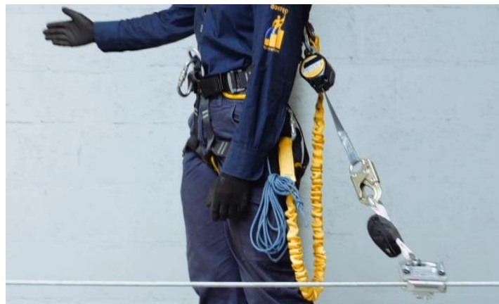
Prawidłowe połączenie urządzeń asekuracyjnych do pracy na dachu kontenera
