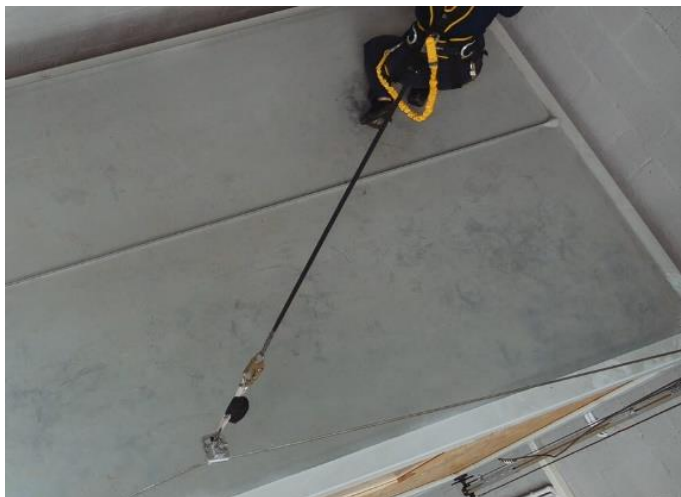
System pracy w ograniczeniu na dachu kontenera
