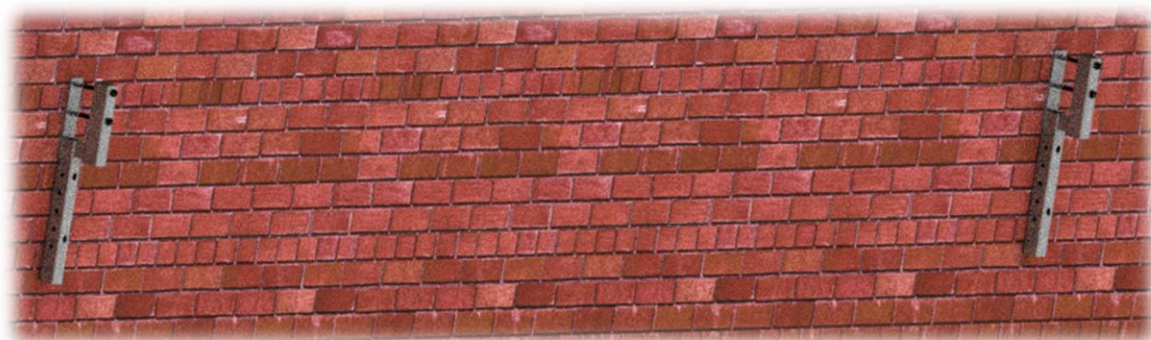
Rys. 15. Rozmieszenie łączników przyściennych.
